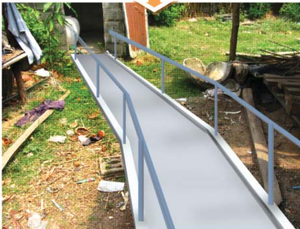
ตัวอย่างการปรับปรุงพื้นทางเดิน พื้นทางเดินควรเรียบไม่สะดุด และติดตั้งราวจับ
