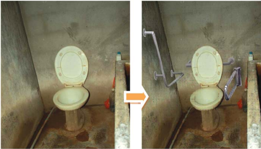
ตัวอย่างการปรับปรุงห้องน้ำนั่งราบ ติดตั้ง ราวจับบริเวณสุขภัณฑ์ และเสริมพนักพิงหลังให้มั่นคง
