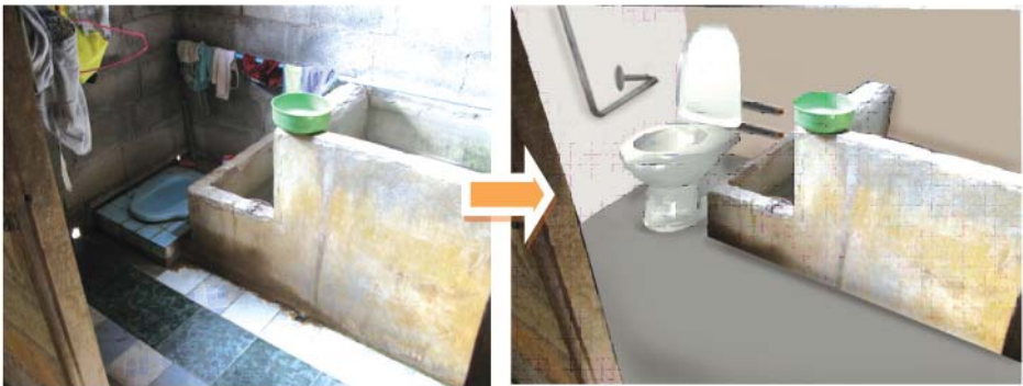
ตัวอย่างการปรับปรุงห้องน้ำนั่งยอง เปลี่ยนสุขภัณฑ์นั่งยอง เป็นนั่งราบ และติดตั้งราวจับบริเวณสุขภัณฑ์
