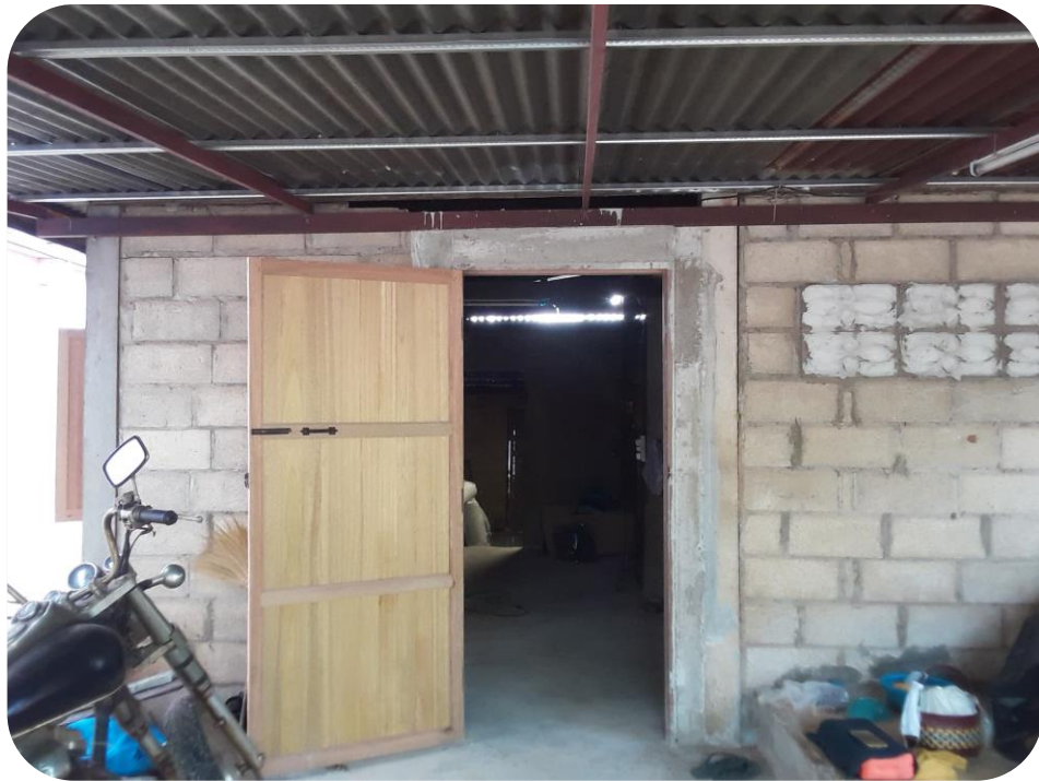
ภาพถ่ายสภาพบ้านหลังการปรับปรุง/ซ่อมแซม เสร็จเรียบร้อยแล้ว
